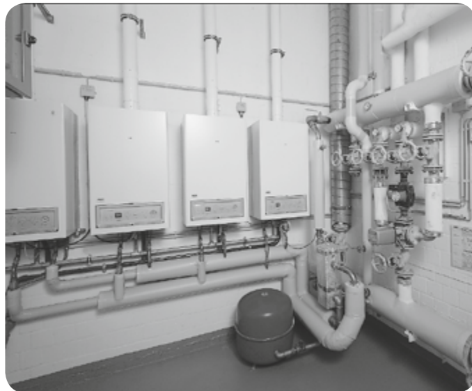
Heizkessel, in Kaskade geschaltet
