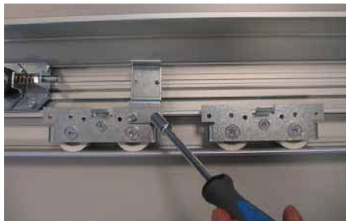
Befestigen Sie die mechanischen Endanschläge [11] im Profil.
