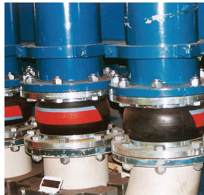
STENFLEX® Typ AS-1 in Kühlwasserkreislauf am Schiffsmotor
