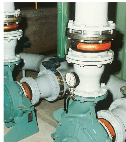
STENFLEX® Typ A-1 eingesetzt an Pumpen
